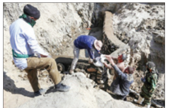
دیوار کشتی و تعمیر لوله‌های آب
